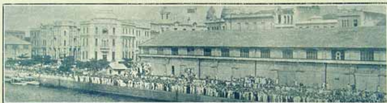
Aspecto do Cães da Porto, armazem 8, por ocasião da chegada da Caravana Democrática
