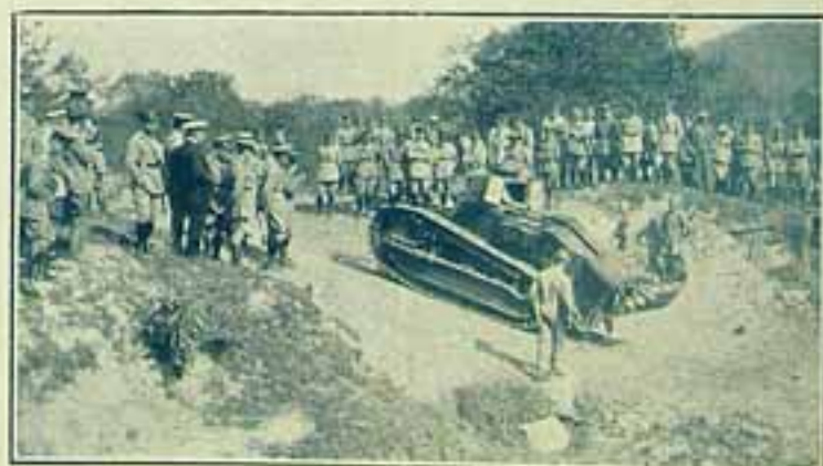
Um tank em manobras
