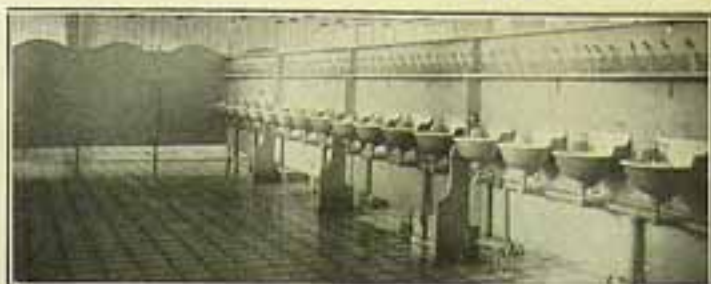
Um trecho do sumptuoso banheiro
