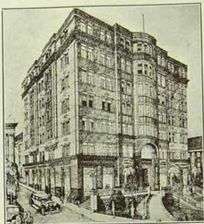
A sede em construcção do vespertino "A Tarde"
