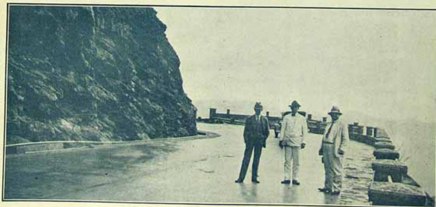
Trecho da Estrada Rio-Petropolis, no alto da serra, mostrando um corte talhado na pedra
