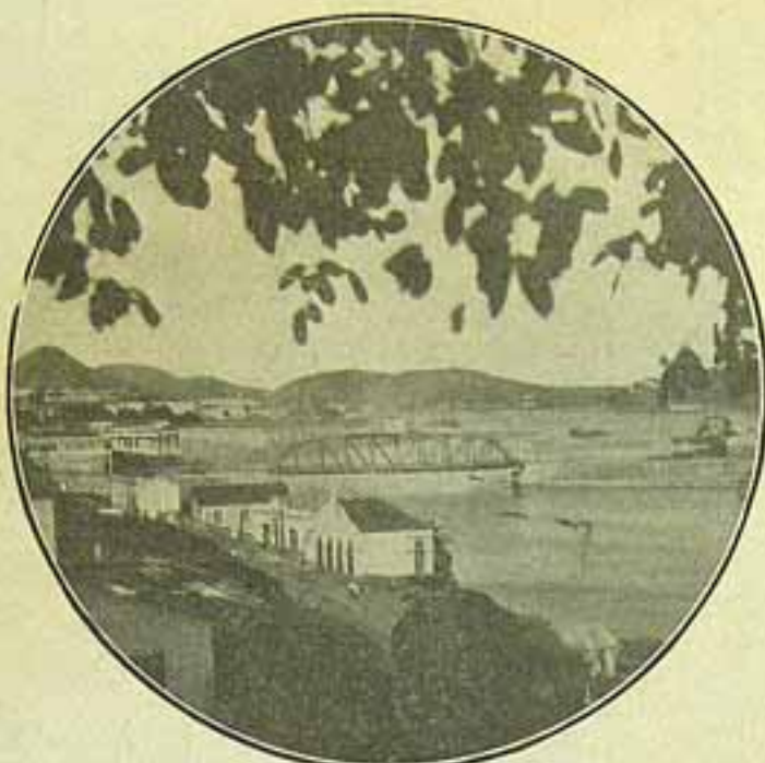
Ponte metallica ligando Victoria ao continente
