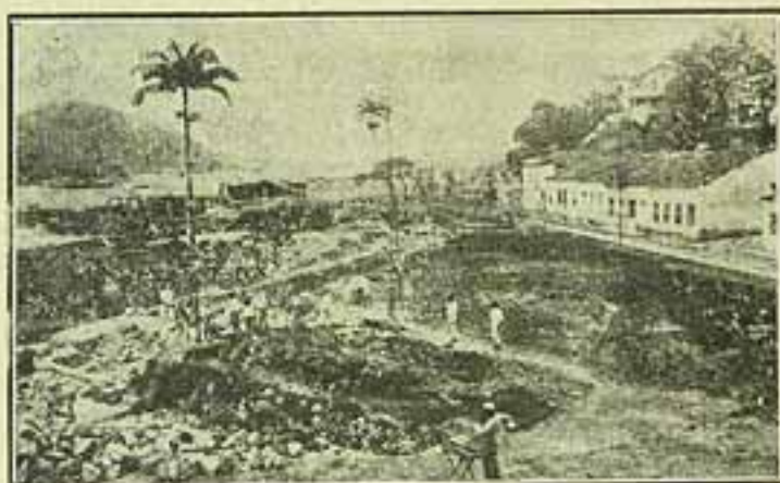
Um dos aspectos das obras já iniciadas
