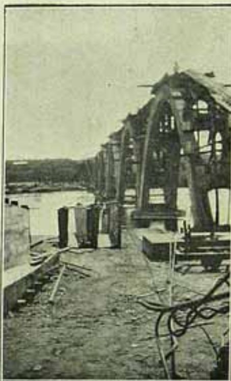
Um aspecto da ponte de cimento armado que está construindo a C. Paulista da bitola larga no Rio de Mogy, em Pitangueiras, E. de S. Paulo.
