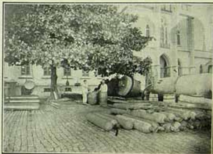
Tubos de ar comprimido prontos para o serviço
