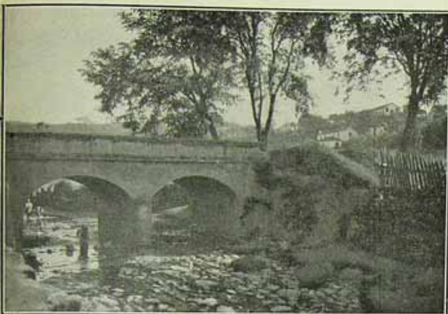
Arganil — Ponte da Barreira
