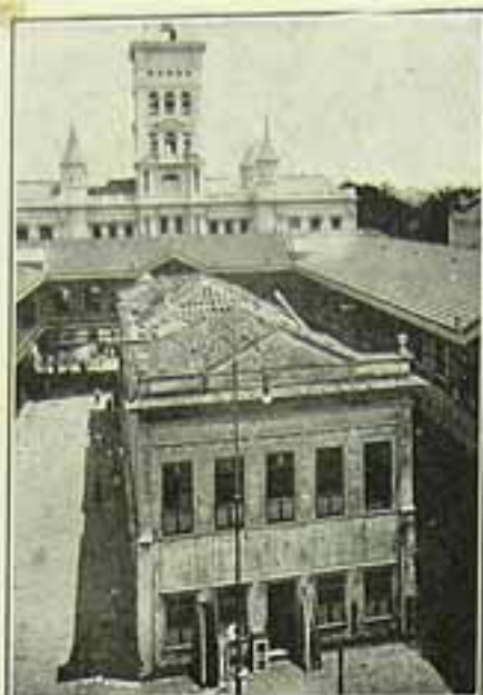
Fachada do quartel central, em 1898
