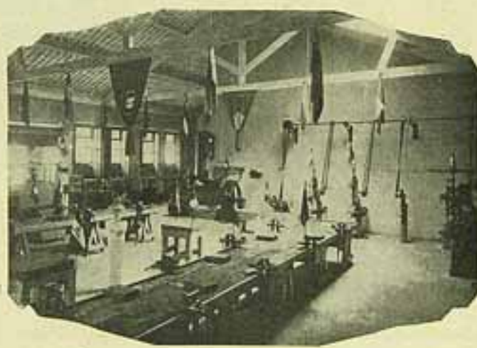
Interior da fabrica de cofres a prova de fogo "LUZITANOS", dos Snrs. Alfredo Mattos & Cia.
