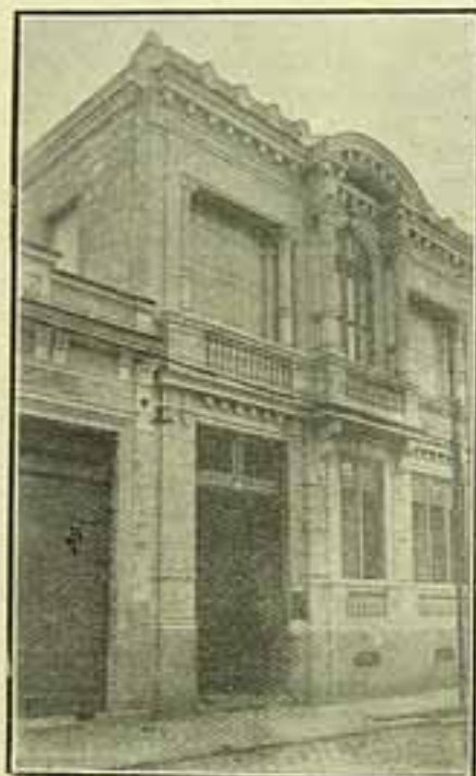
O edificio do Hospital
