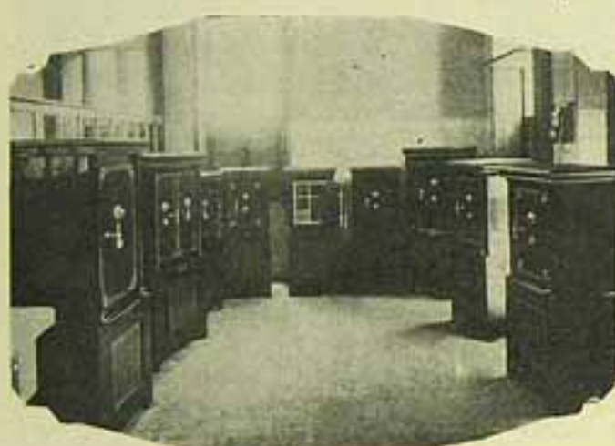
Sala de exposição de cofres a prova de fogo, na fabrica "LUZITANOS", dos Snrs. Alfredo Mattos & Cia.
