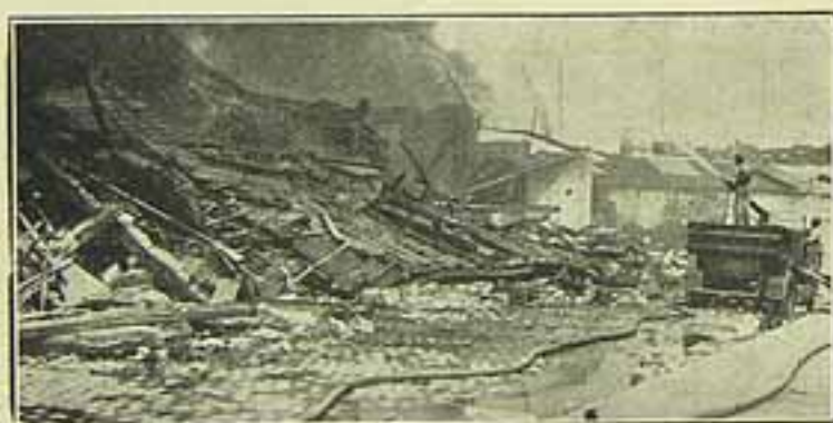
Os escombros do edifício da Navegação Costeira, incendiado em 15 do corrente.
