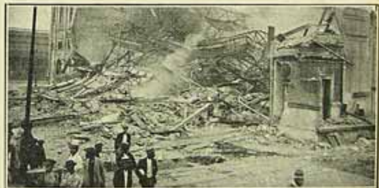
O vigamento de ferro do grande edifício completamente torcido pela violência do fogo.
