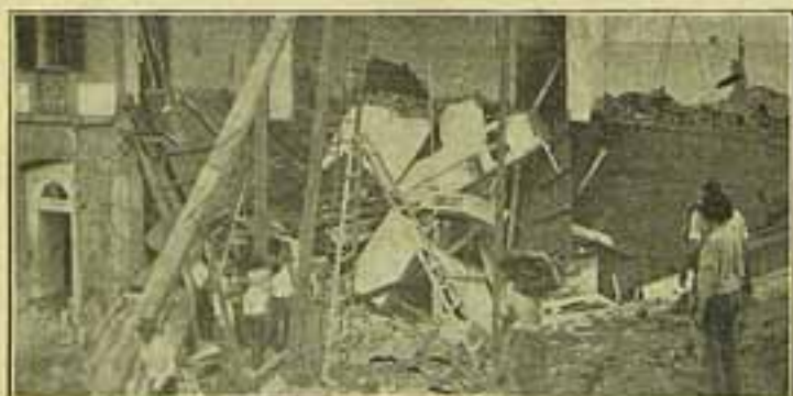
O estado em que ficou o necrotério da Santa Casa.
