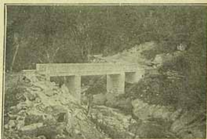
Ponte do Roncador sobre o Rio Sebastiana, estrada Rio-Therezopolis, com um vão de 15 metros.
