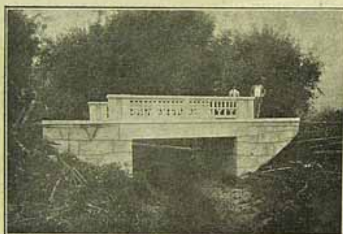
Ponte sobre Rio Petropolis, na Estrada Therezopolis-Friburgo com um vão de 17 metros.
