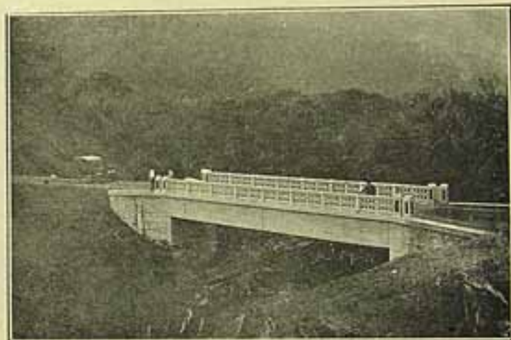
Ponte sobre o Ribeirão do Prata, na Estrada de Varzea a S. José do Rio Bonito, com um vão de 8 metros.
