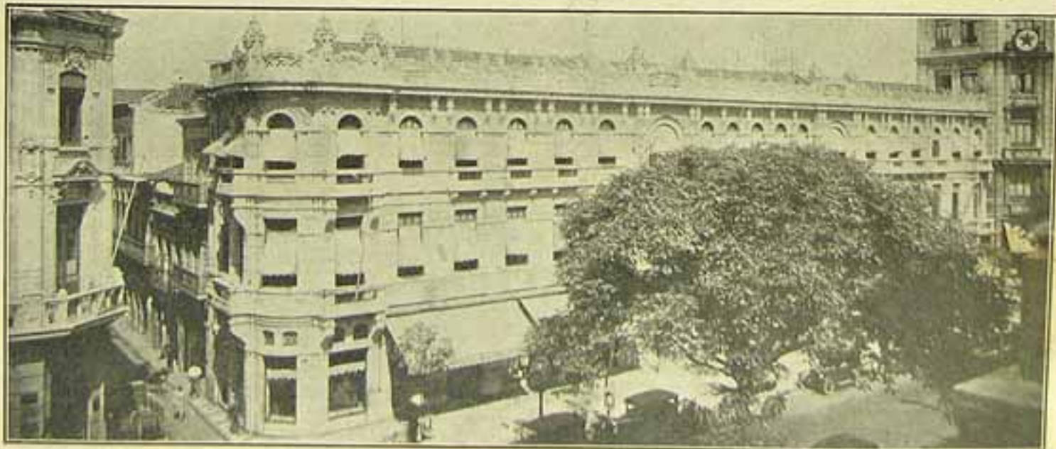
Edifício da "General Electric", onde trabalha a senhorinha Altair Desouzart
