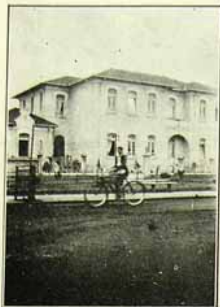
Edifício do 1º Grupo Escolar
