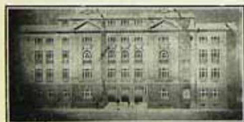
Edifício da Secretaria de Segurança Publica — Bello Horizonte.
