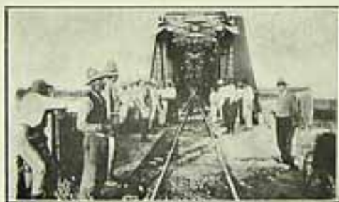
Aspecto dos serviços na ponte da Noroeste, sobre o rio Paraná.
