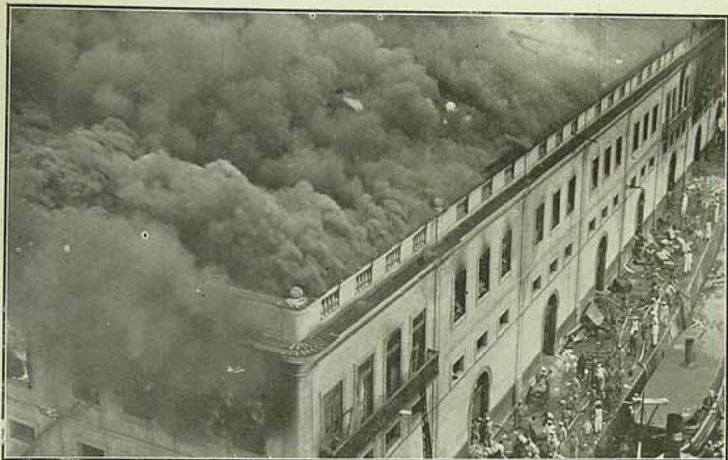
O fogo envolvendo todo o corpo do edificio
