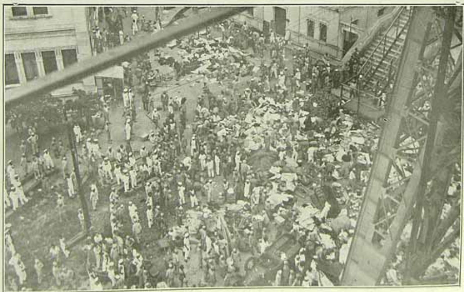
Outro aspecto dos "salvados" atirados proximo ao incendio
