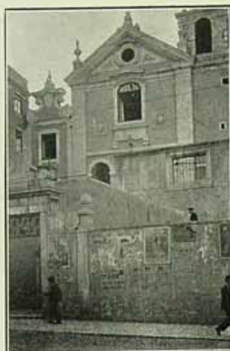
Aspecto recente da igreja do Convento dos Mariannos.
