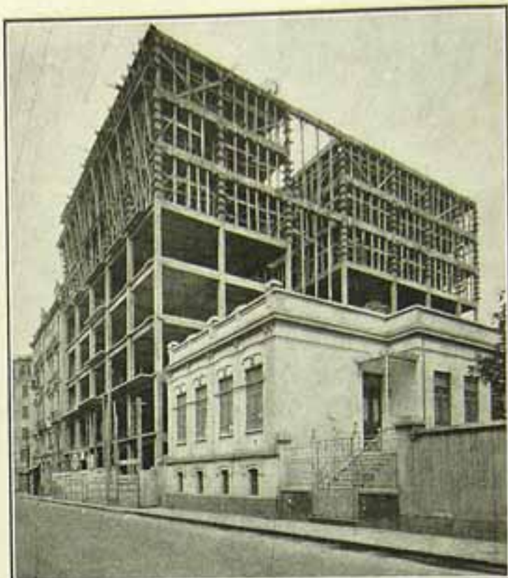
Arranha-céu em construção na antiga residência do Dr. Washington Luiz, á rua Victoria.
