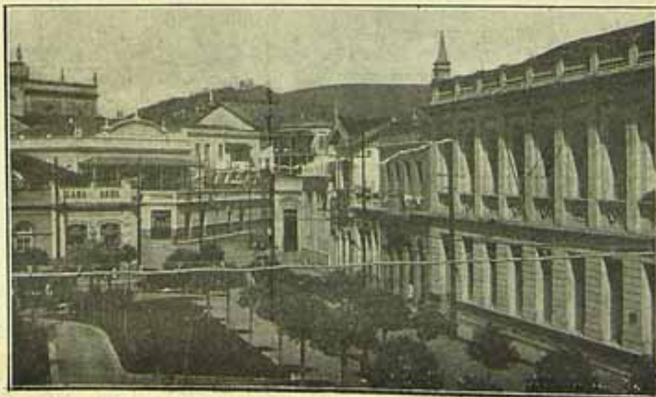
Detalhe da cidade, vendo-se o Grupo Escolar
