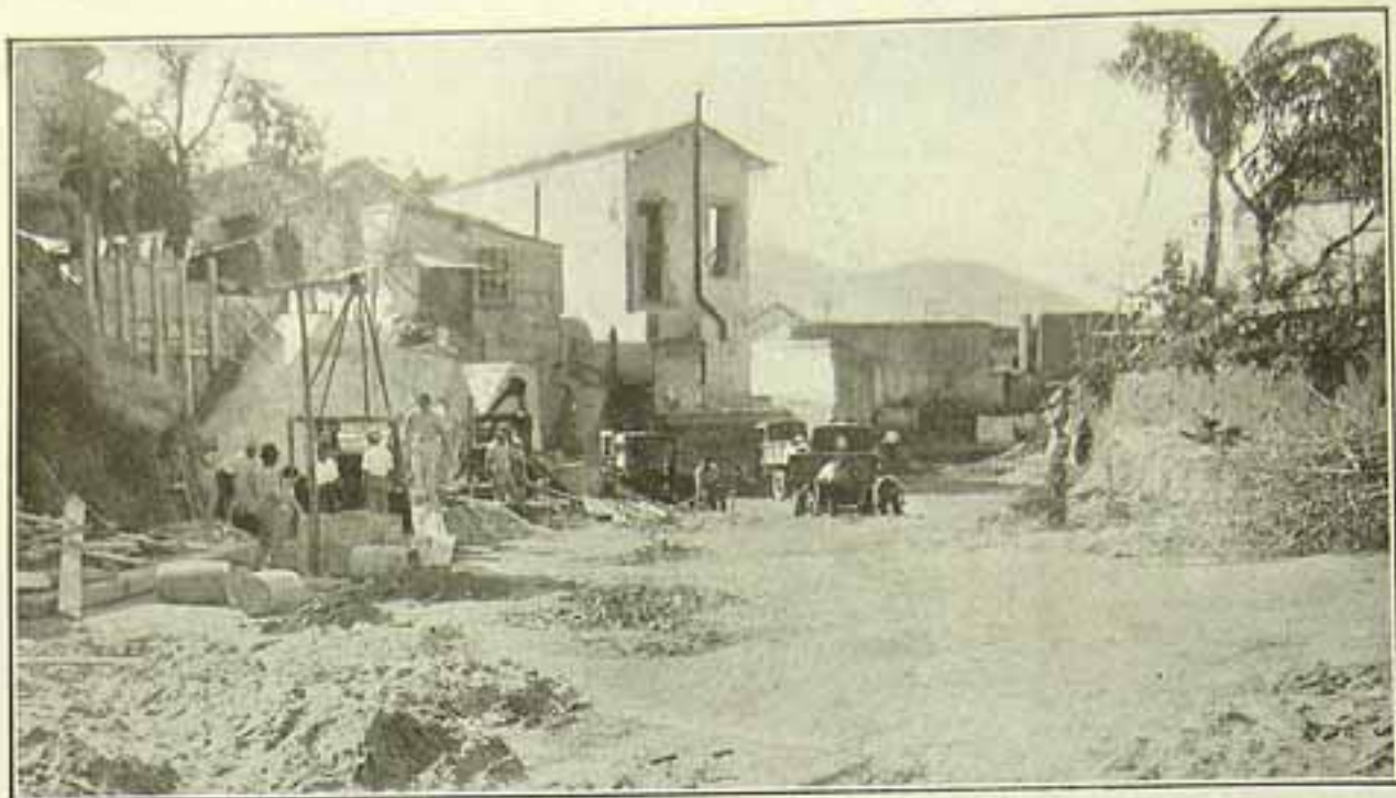
Aspecto das desapropriações para o alargamento do Tunnel Velho.
