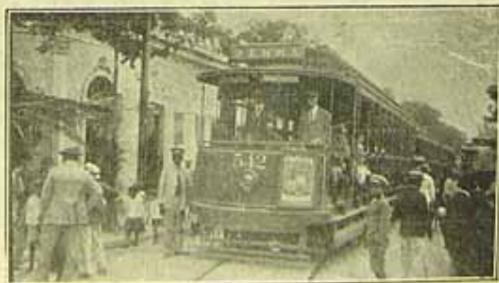
O primeiro bonde da Light que trafegou para a Penha, no ultimo domingo.
