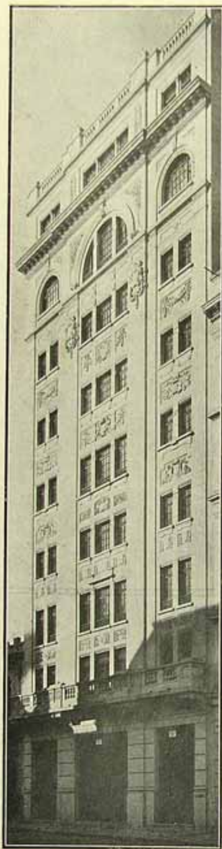
Predio Itaquerê, de propriedade do Sr. Carlos Leoncio de Magalhães, á rua Salvador Feijó, 27, onde está instalada a succursal da Sociedade Anonyma "O Malho".
