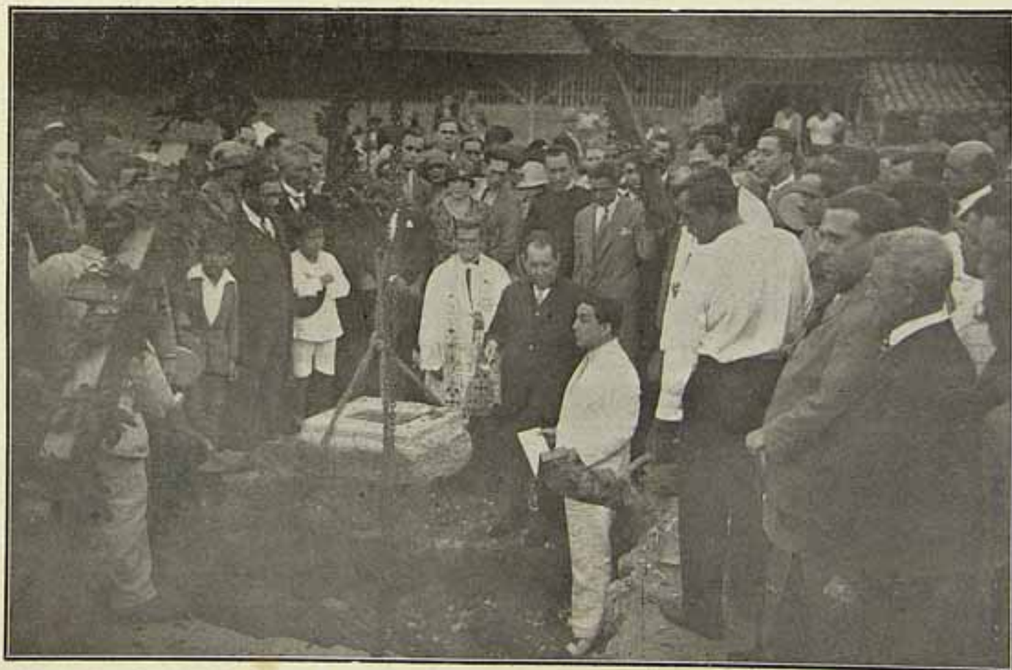
Cerimonia da collocação da primeira pedra do Matadouro Modelo, vê-se o presidente Sodré no momento em que collocava a primeira pá de cimento.
