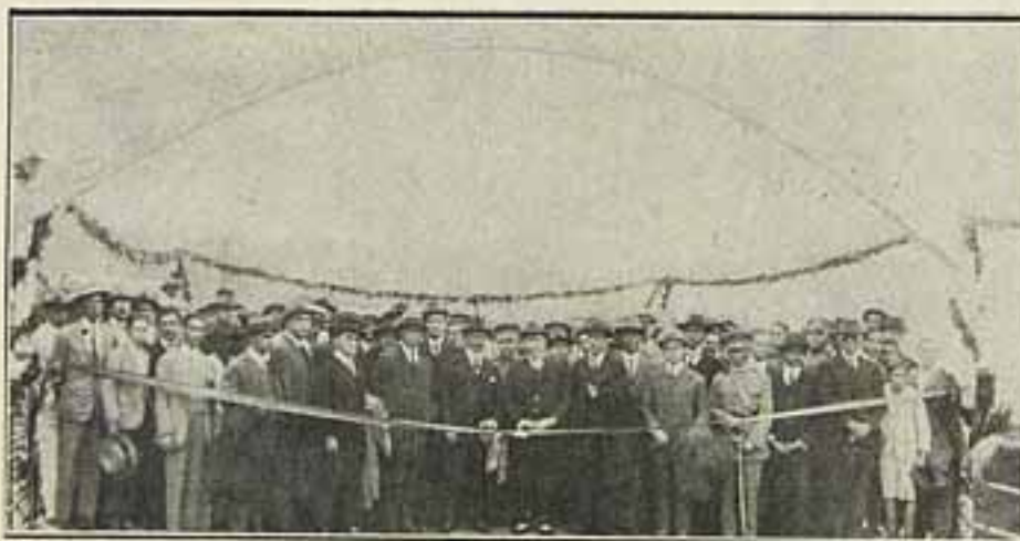
Inauguração da ponte interestadual sobre o rio Itabapoana, construída pelos governos do Estado do Rio e do Espírito Santo, vendo-se os presidentes Feliciano Sodré e Florentino Avidos. Essa bella ponte, de concreto armado, liga Bom Jesus de Itabapoana, progressista districto de Itaperuna, ao de Bom Jesus do Norte, pertencente ao municipio espirito-santense de S. José do Calçado.
