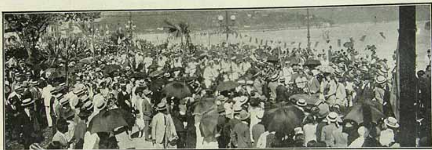
Os aviadores assistindo a inauguração da placa comemorativa da chegada do Jahú, em Icarahy
