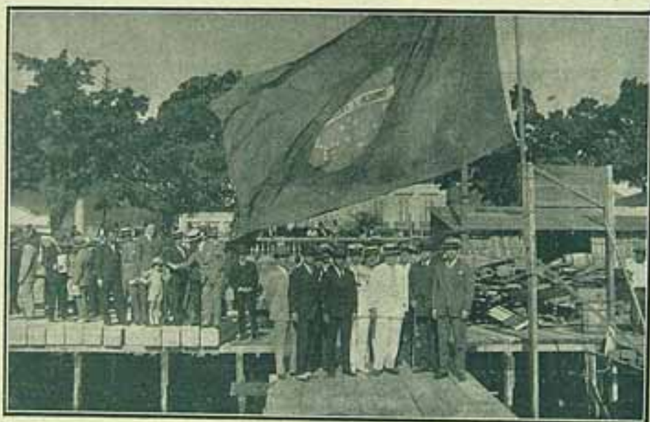
Lançamento da pedra fundamental do Yacht Club, na praia da Saudade
