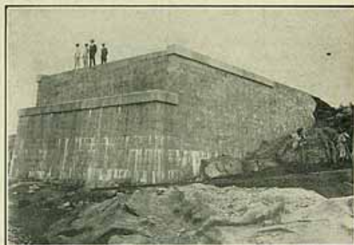
Vista do lado Norte, vendo-se a muralha para o encontro da ponte sobre o canal Sul, já concluída — Ilha do Príncipe.
