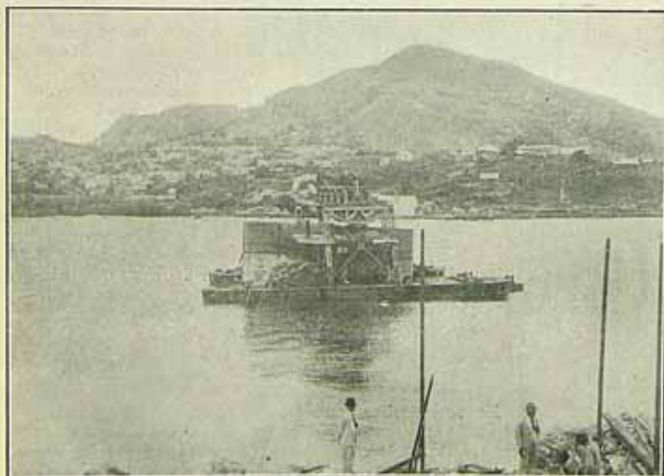
O caixão localizado no seu ponto antes de ser submerso. Ao fundo vê-se terra firme.
