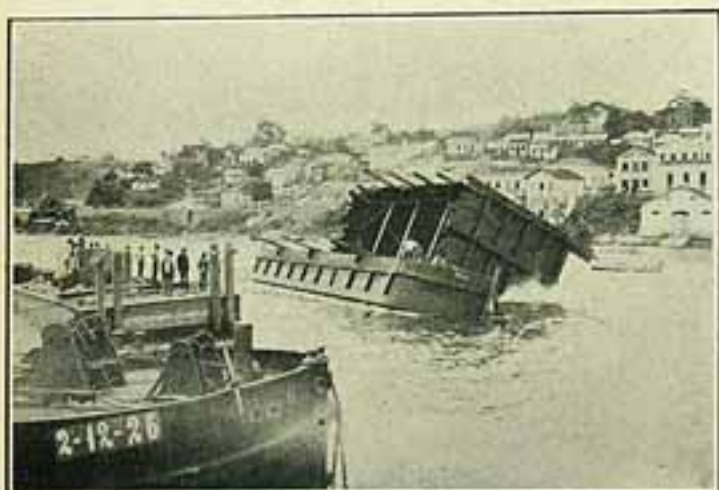
A enseccadeira para o encontro da ponte sobre o canal Norte, no dia do seu lançamento ao mar, na Ilha do Príncipe.
