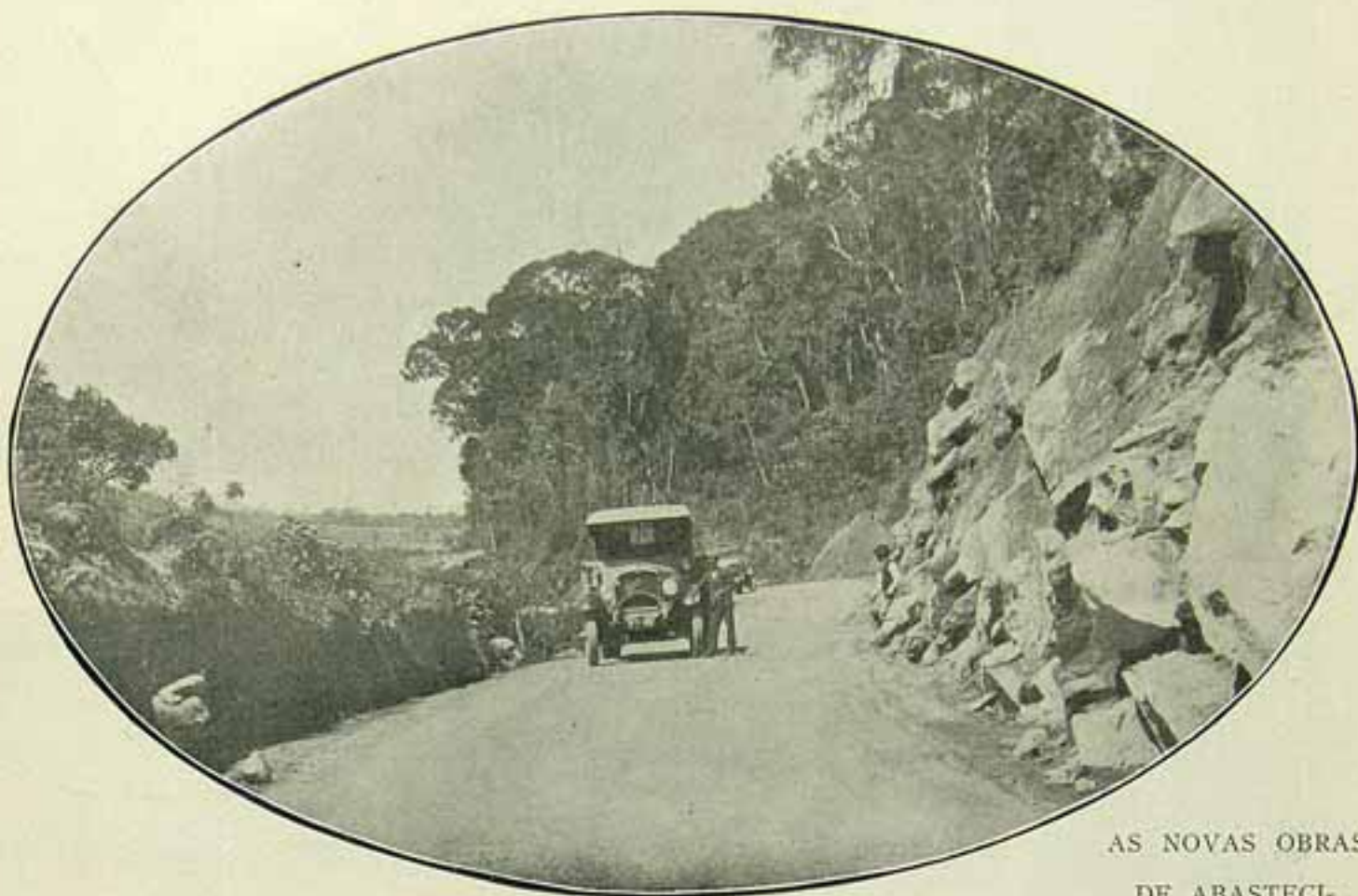
Estrada de rodagem do Rio Claro, a melhor do Estado de S. Paulo pela sua construção, traçado e conservação.
