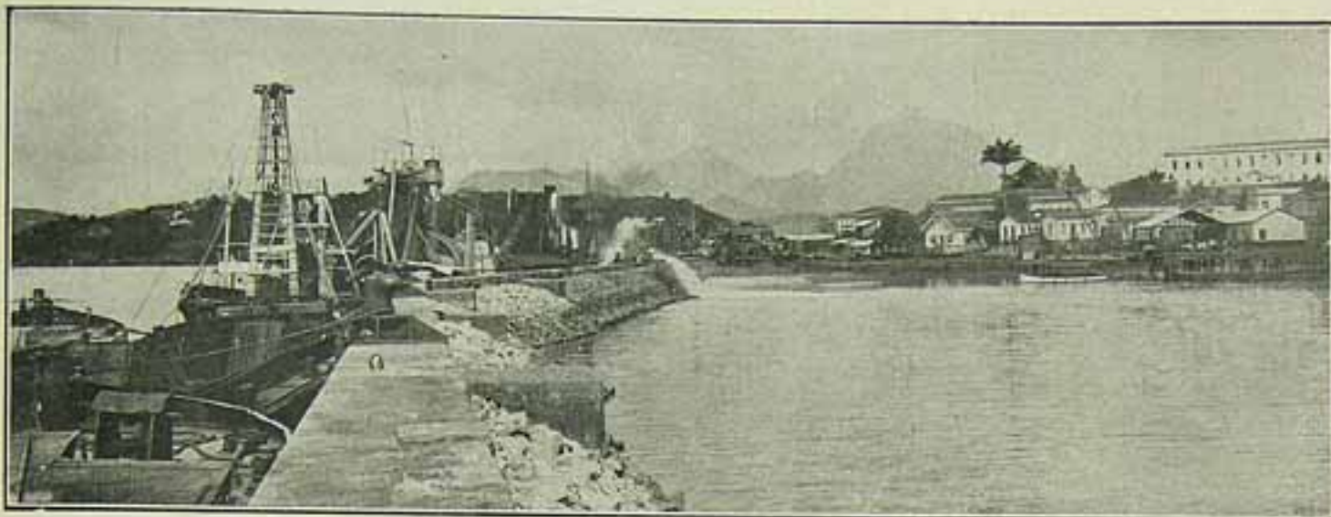
Um trecho de Victoria, que está sendo construído pelo presidente Florentino Avidos. Ao longe se vê uma das dragas de sucção em pleno funcionamento no aterro da area do cães.
