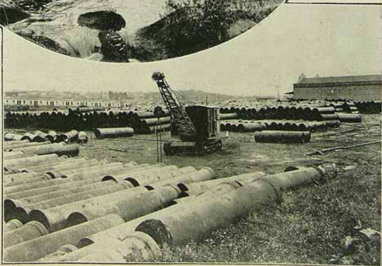
Oposito de tubos de ferro fundido de de o, m80 e o, m90 de dia- metro para a distribuição das aguas.
