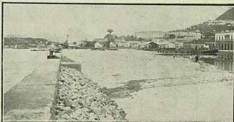
Outro aspecto do mesmo trecho, no qual se vê a parte já construída pelo actual governo espirito-santense.
