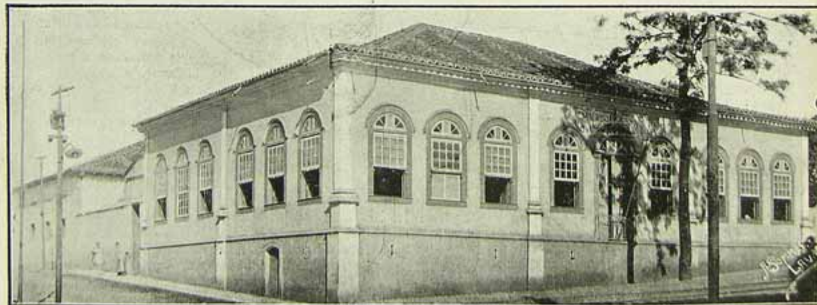
Edifício em que funcionam respectivamente a Academia de Commercio, Escola Nocturna e Escola Parochial, em Lavras — Minas.
