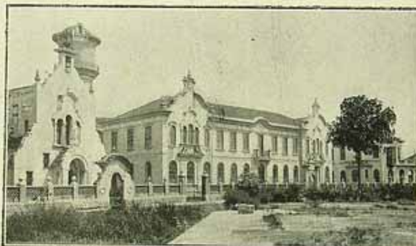
Vista parcial da construção
