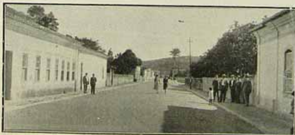
Aspecto da rua Eusebio de Queiroz macadamizada na passada administração municipal
