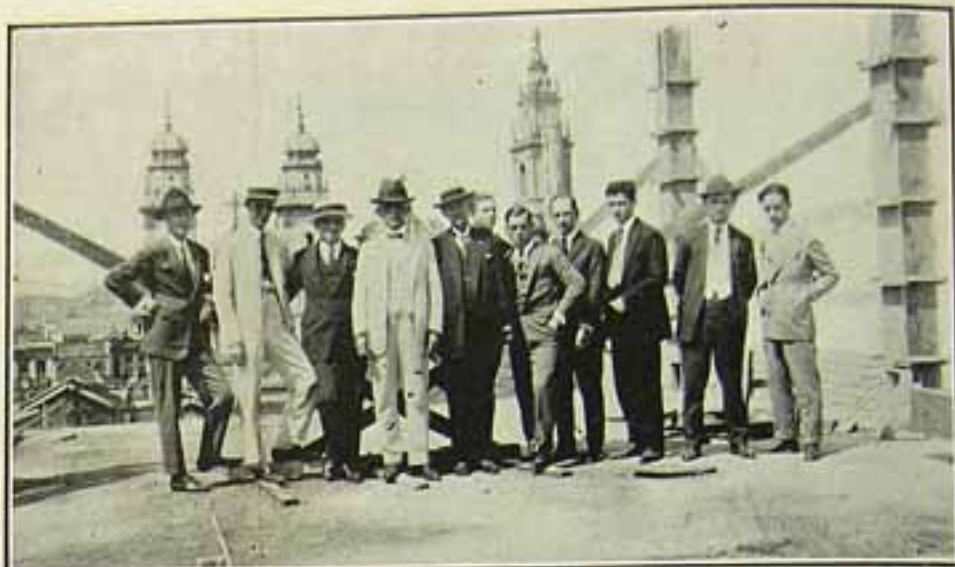
Os directores Felix Mascarenhas e Bianor de Medeiros. O thesoureiro Aldo Vasconcellos e outros empregados do Banco Popular do Brasil, na placa de cimento armado no 5º andar do novo edificio, em construcção, à rua da Quitanda n. 79.
