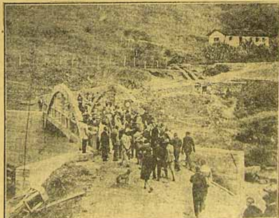
Na estrada de Vassouras, em Massambard, ponte "Luiz da Rocha Miranda", sobre o rio Uba, com 22 metros de vão.
