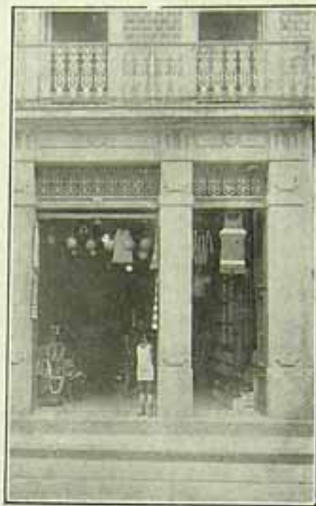
A entrada da "Casa Spander" pela rua Buenos Aires, 75
