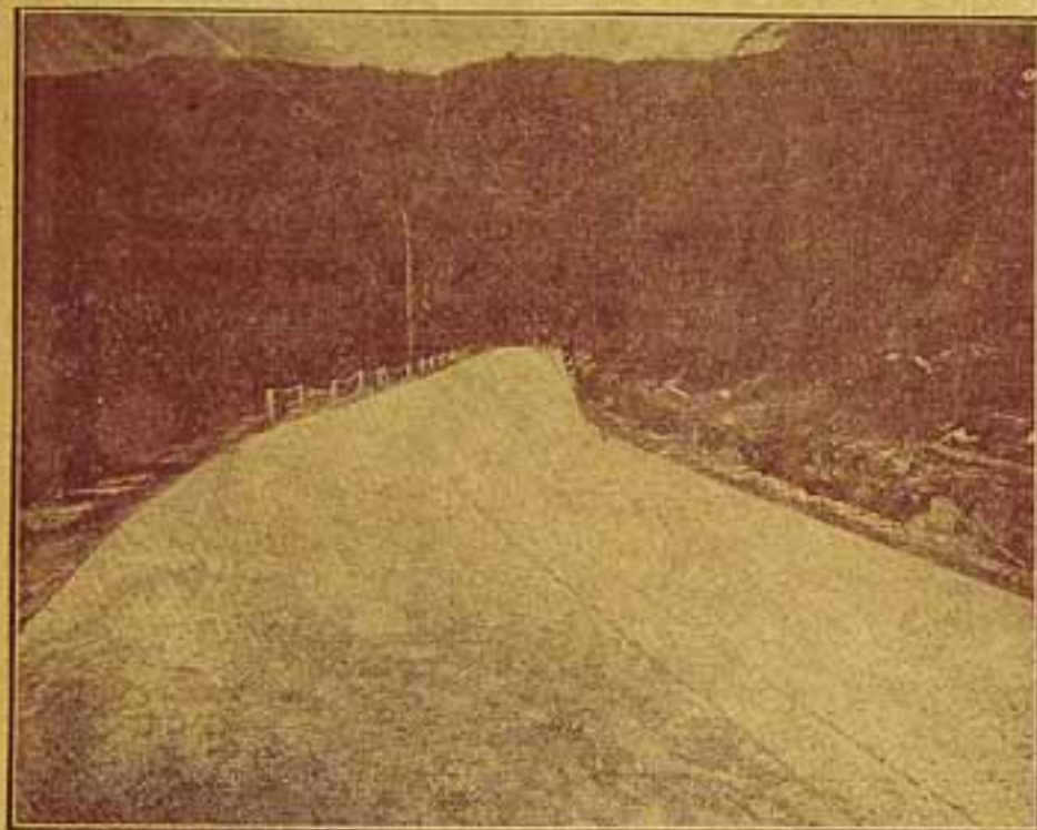
Trecho já cimentado na Serra do Mar — Estrada de Santos
