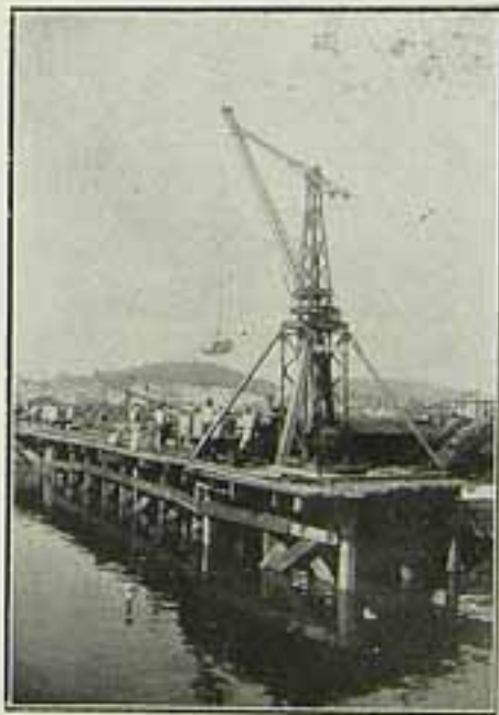
Ponte de carga e descarga dos materiais. Comp. Nacional de S. A.
