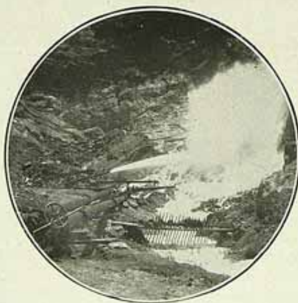
TUBULAÇÃO DA DRAGA PARA RECALQUE DO MATERIAL.
