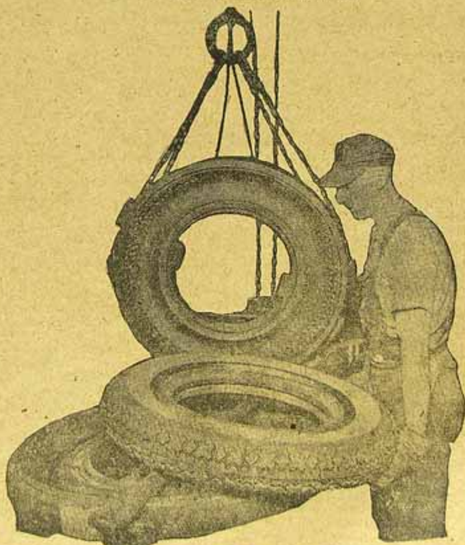
O pneumatico ao ser retirado da forma de aço. O molde se faz num profundo poço de aço e sob grande pressão.
