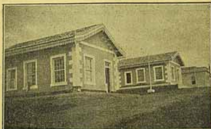
Residencia dos funcionarios da Estação
