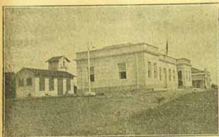
Edifício central da Estação
