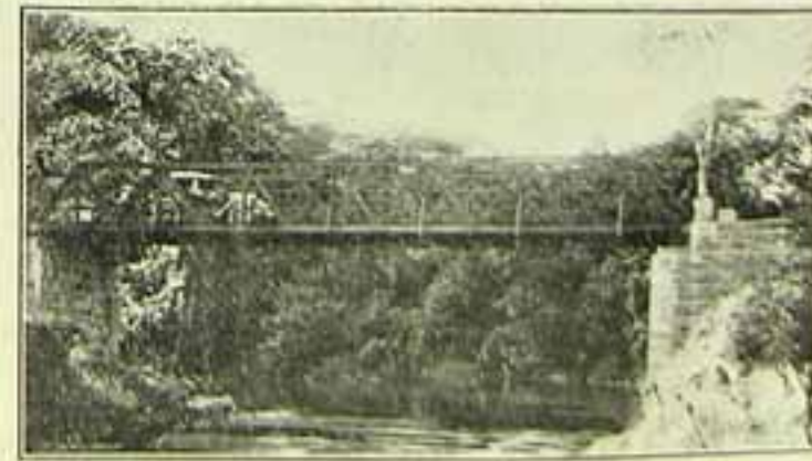
Ponte metallica do Rosetal sobre o Rio das Flores, com 20 metros de vão, na estrada de automovel Sta. Theresa-Barraão.
