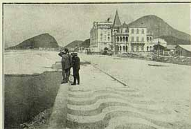
Obras da Avenida Atlantica
