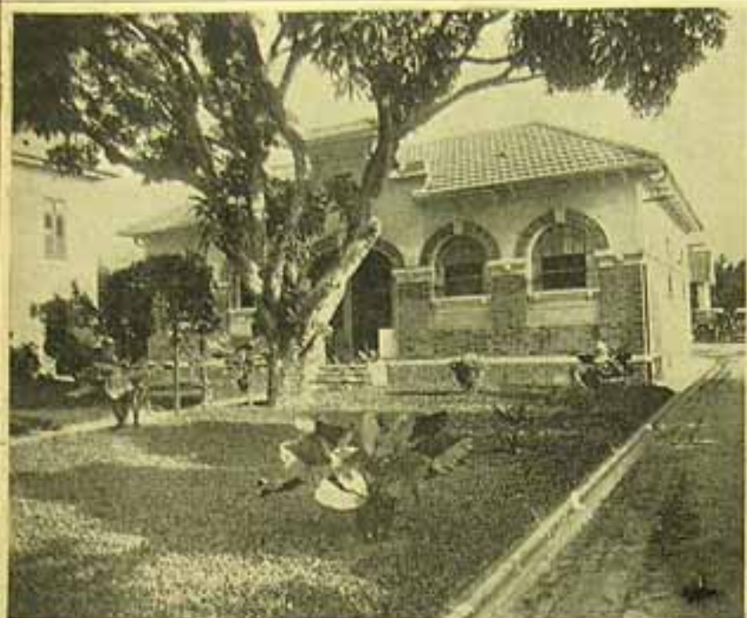
Edifício principal da fábrica
