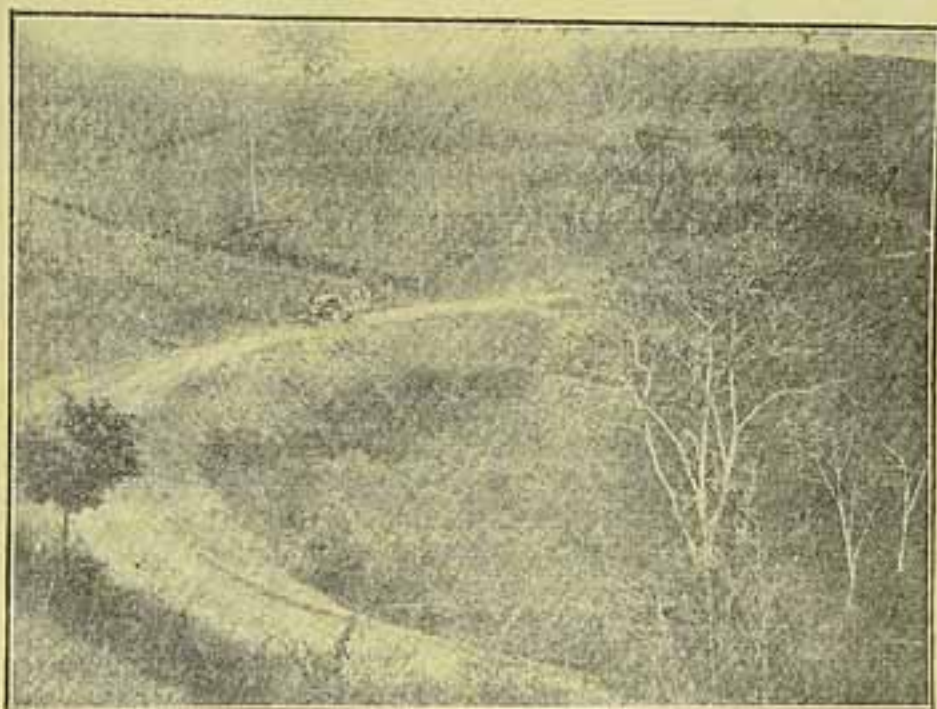
Estrada Cataguazes-Tocantins-Ubá, com 56 kls. e 8 % de rampa maxima. As curvas accusam o raio minimo de 30 metros. Essa estrada liga o tronco da Motta à União Industria.
