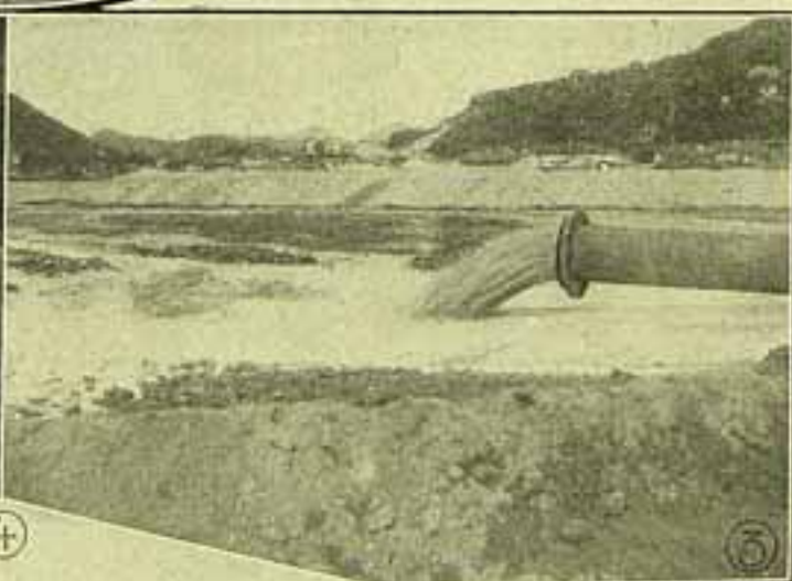
4) Aterro alcançado com desmorte por meio de aparelhos hydraulicos, na enseada de São Lourenço. Como se vê pelas gravuras, as obras são dignas de todos os louvores.
