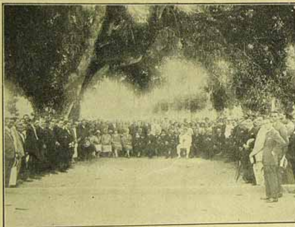
Inauguração do Pavilhão de Observações no Hospital de Doenças Nervosas e mentaes.
