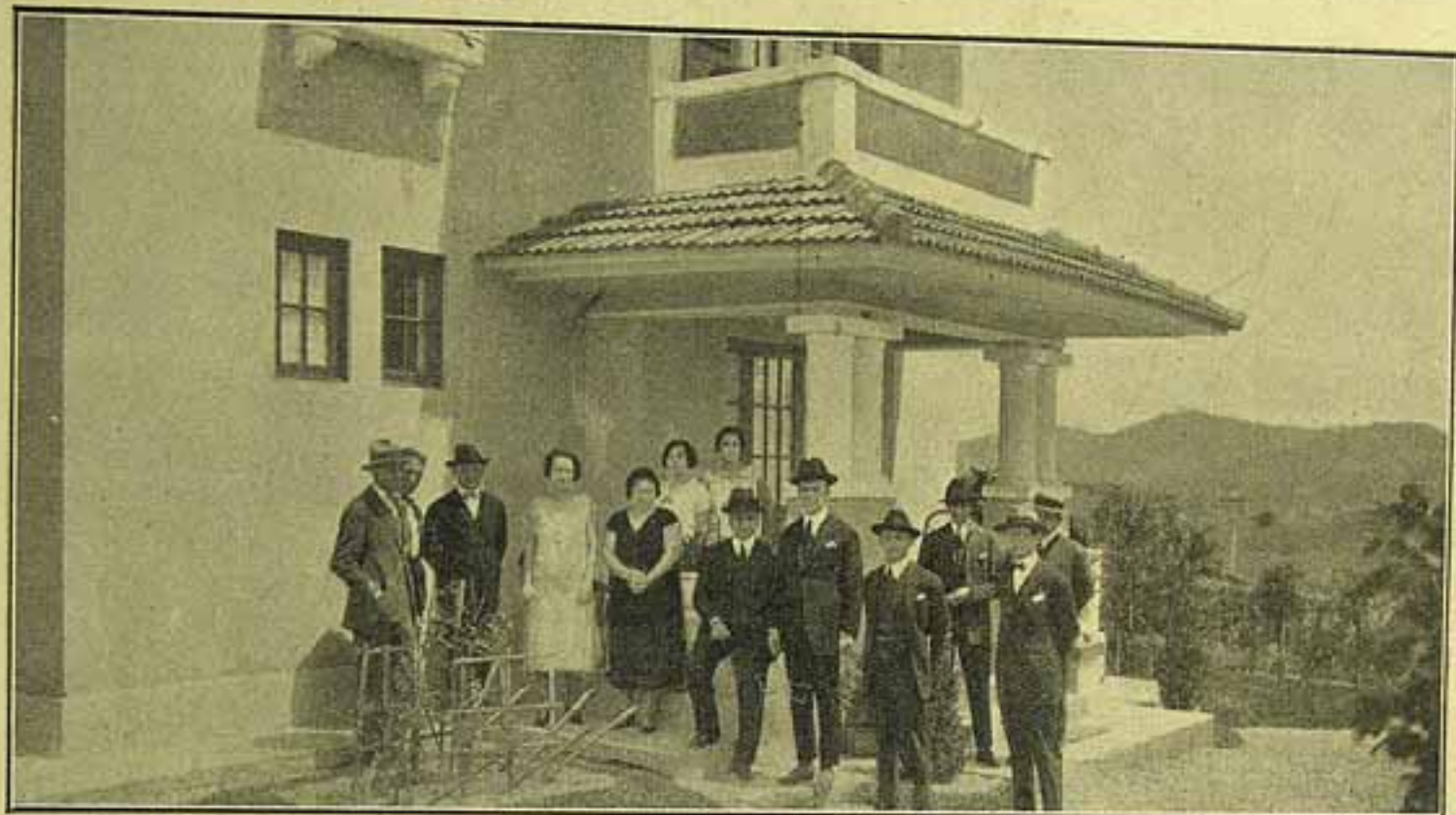
Visita ao prédio construído pela Companhia e de propriedade do Sr. Miguel Pereira Machado, sócio da Casa Carvalho.
