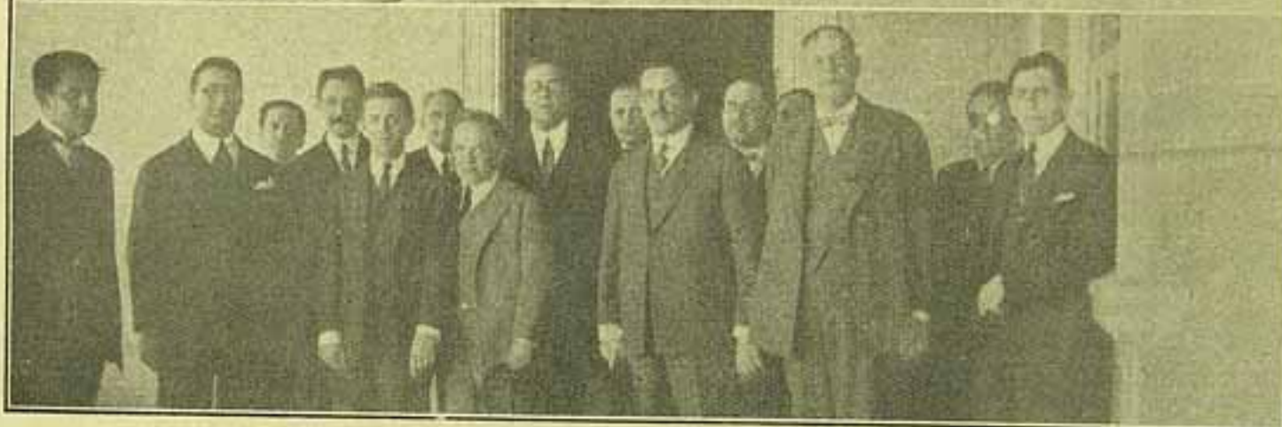
Visita à galeria n. 5, das minas da Comp. Santa Maria. Na Estação de Bello Horizonte
