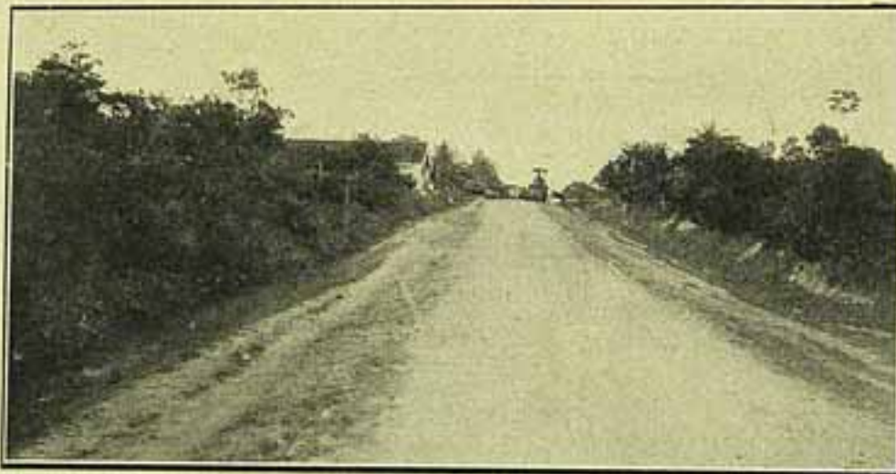
Aspecto de um trecho da estrada de rodagem de Recife á Victoria, quando em macadamisação
