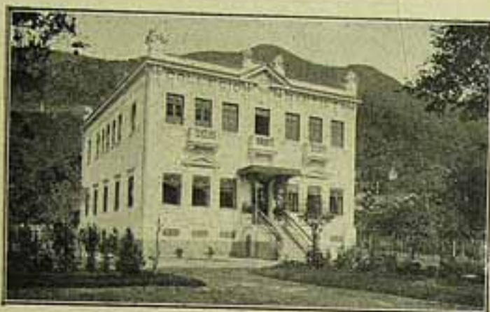
Edifício do collegio para o sexo feminino (Rua Conde Bomfim, 743)
