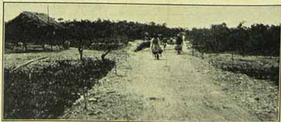
Trecho em construcção da importante via-ferrea C. E. de F. Norte de Matto Grosso, que liga S. Paulo áquelle futuroso Estado. Plano traçado pelo grande brasileiro general Rondon, está agora sendo executado pela empresa concessionaria á frente da qual se acha o illustre patricio Oscar Mesquita.
