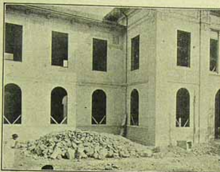
O hospital em construção
