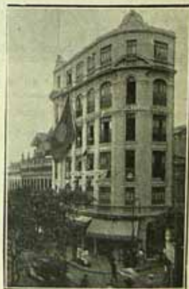
Predio em que funcçãoa a Companhia A CONSTRUCTORA, á rua Uruguaya, 112 - 2º
