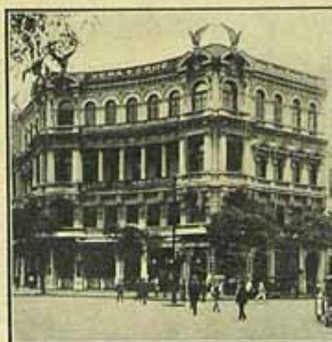
Edifício onde funciona a Companhia Vera-Cruz.
