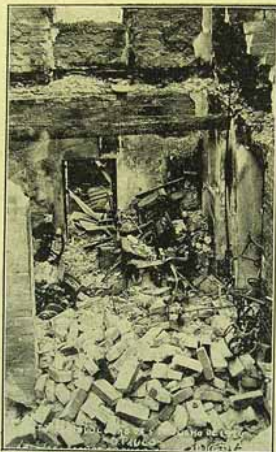
Estado em que ficou o prédio da Avenida Lacerda Franco n. 1
