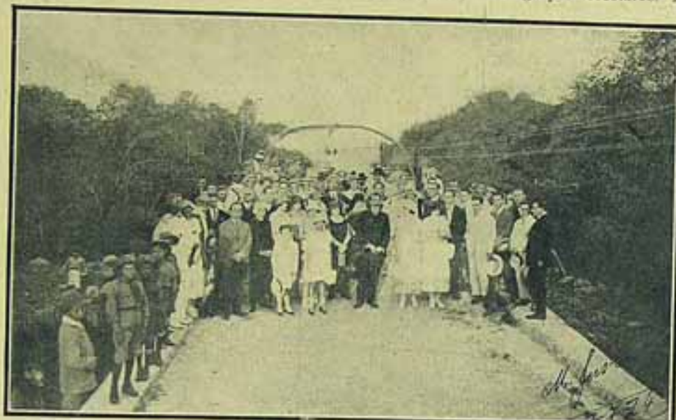
Inauguração da Ponte "Arthur Bernardes", de concreto, medindo 30 metros, com largura útil de 5 metros, realisada a 7 de Julho de 1924, vendo-se presentes o Exmo. Sr. presidente Ildefonso Albano, o orador official Dr. João Octavio Lobo, senhoras e outras pessoas gradas.
