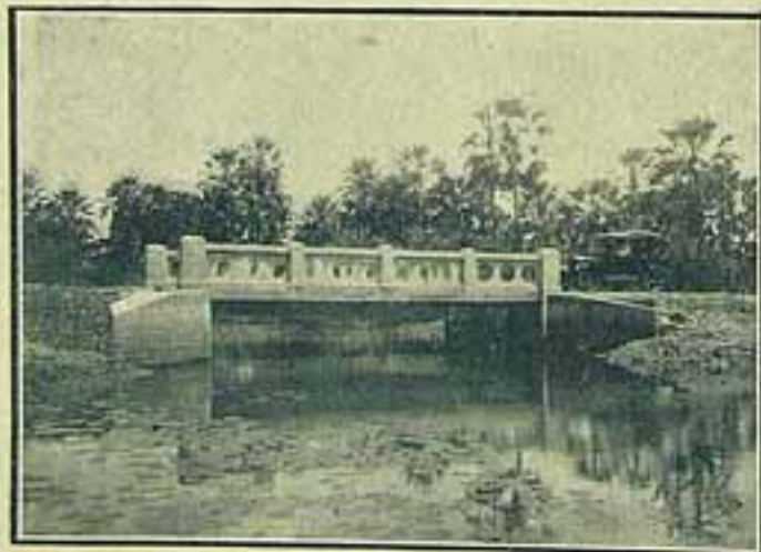
Ponte Justiniano de Serpa, de concreto, sobre o rio Cócó, medindo 9 metros, com largura útil de 5 metros, iniciada pelo presidente Ildefonso Albano em Agosto de 1923 e por elle inaugurada a 26 de Fevereiro de 1924, sendo orador official o Dr. Alberto Moreira.
